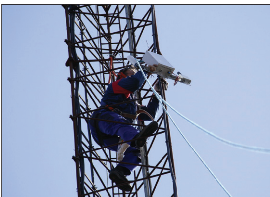
På dette foto ses OZ5TG, Verner, montere de to beacons i 35 meter højde. OZ5BZ og OZ9ZZ har stået for det meste af ombygningen og er nu i gang med de resterende beacons til 1,3/2,3/3,4/5,7 GHz.
